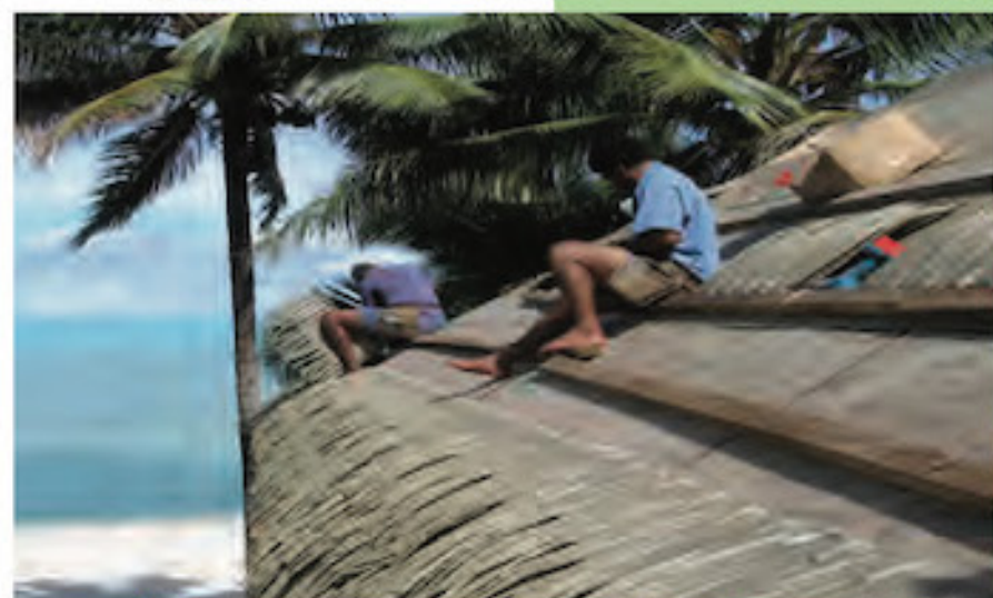
Montage d'une toiture Rio à Aitutaki, Îles Cook
