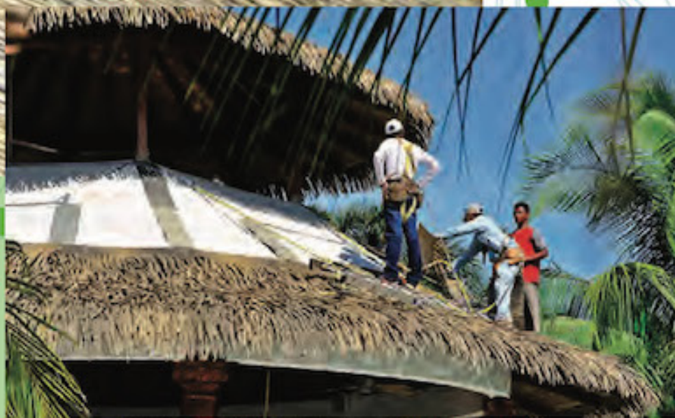
Panama, installation d'une toiture Domingo
