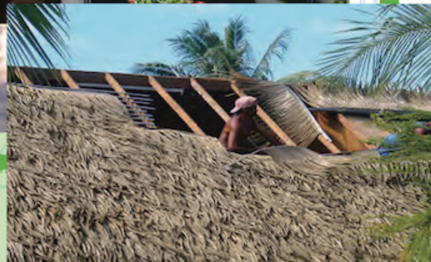
Montage d'une toiture Aloha, Polynésie française
