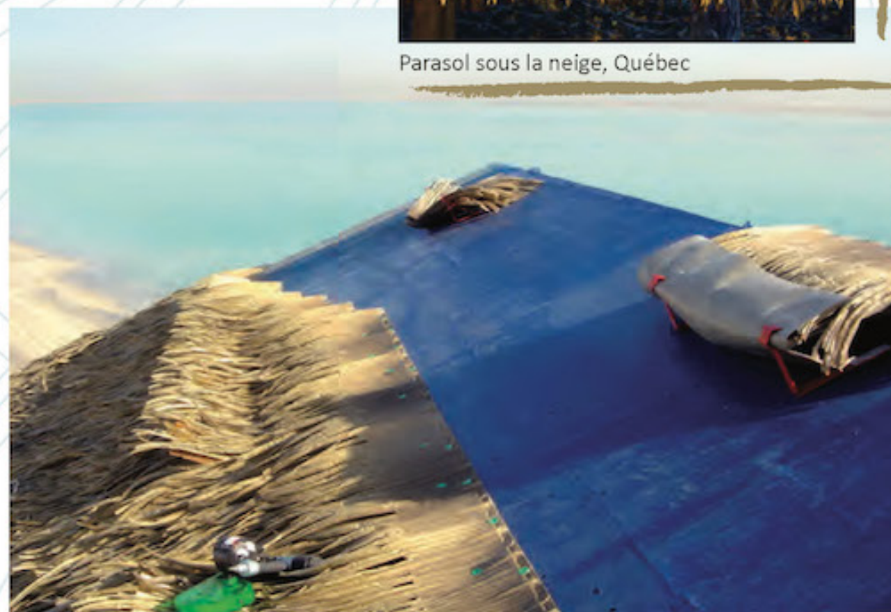
Montage d'une toiture Domingo à Dubai, Emirats Arabes Unis
